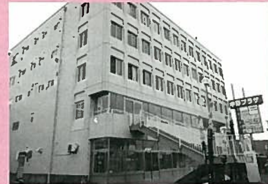
入居する「中野プラザ」ビル
