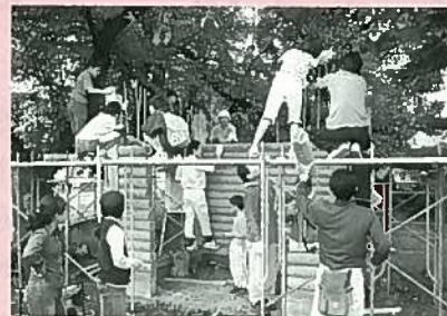
ログ組み立て作業
