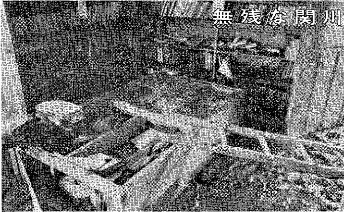
㊦ 濁流に打ちのめされた関川村公民館図書室
